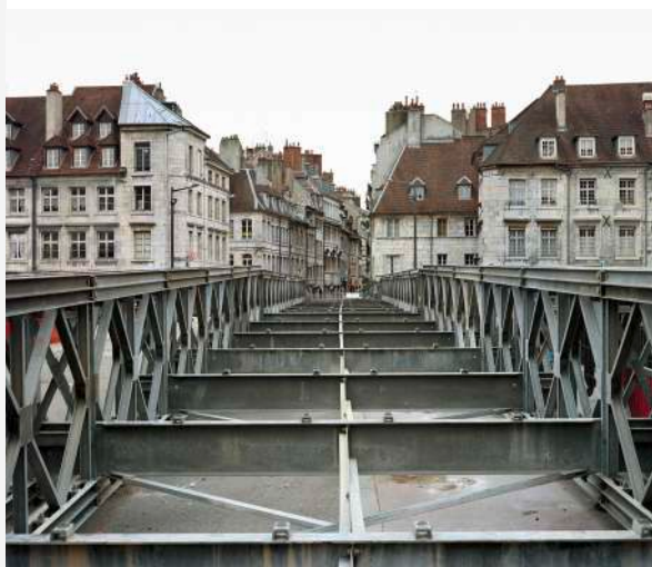
Reconstruction du Pont Battant, Besançon, 2013 © Christophe Monterlos
