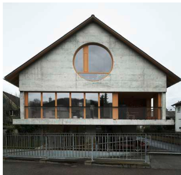
Immeuble collectif Baselstrasse MuttENZ, Felippi Wyssen Architekten © Valentin Jeck
