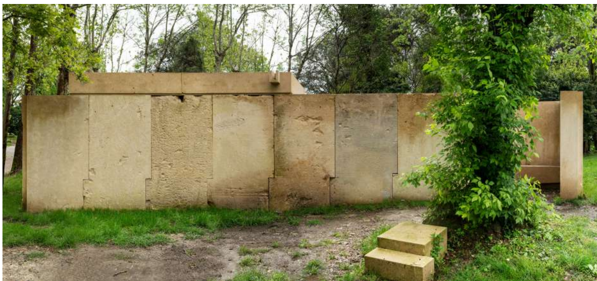
Barrage Foz Tua © photo prise par Carlos Castro
