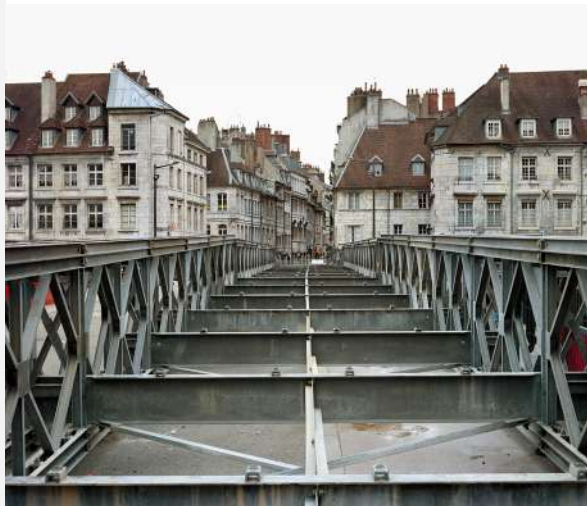
Wiederaufbau der Brücke Pont Battant, Besançon, 2013 © Christophe Monterlos
