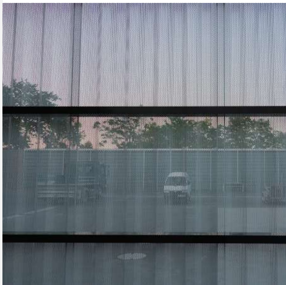
Nordfassade, Betriebshof Friedhof Mannheim, motoplan, 2017 © Bernhard Wondra
