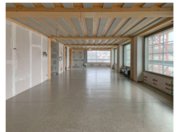
Amt für Umwelt und Energie, 2021, Basel, Baustellenbild. Architektur © jessenvollenweider architektur
