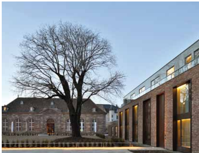
Brasserie Hôtel Les Haras, Strasbourg – Architecte : DENU & PARADON Architectes – BET Fluides et Électricité CEREC Ingénierie
