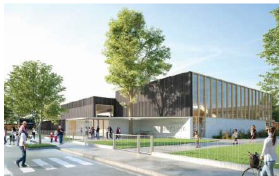
Gymnase de la Canardière ©F+F architectes
