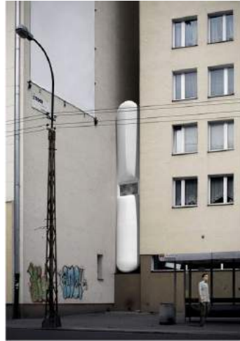
VARSOVIE, Pologne : Projet Keret House, CENTRALA Architects. 1,33 m de large sur 12 m de long, l'escalier est rétractable.
