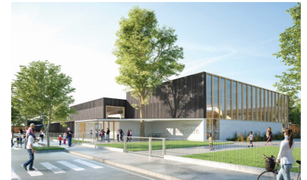
Gymnase de la Canardière ©F+F architectes
