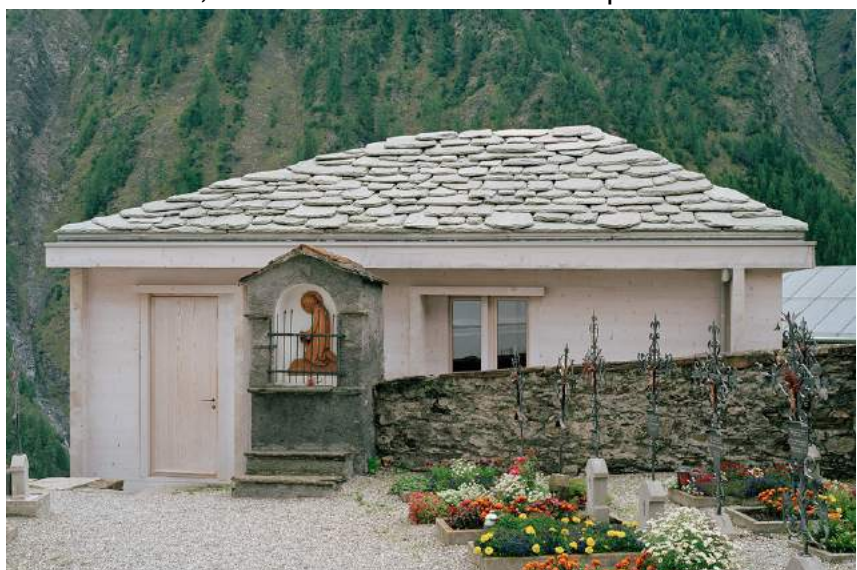
La Stiva da morts – Vrin – Gion A. Caminada - 2003
