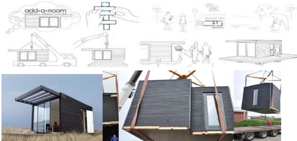
**Swisswoodhouse** ist eine Kooperation zwischen **RENGGLI SA** und **BAUARTarchitectes** aus der eine Übertragung der Modulbauweise auf Wohngebäude, ausgehend von einem 25 m<sup>2</sup>-Modul resultiert. Die Käufer/-innen gestalten ihr Haus selbst aus einem Katalog, wobei sie einzelne Module mit hoher Nutzungsflexibilität kombinieren. Diese Holzkonstruktionen erfüllen die Voraussetzungen für die Langlebigkeit der Gebäude.
