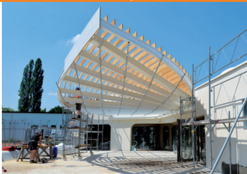
Accueil de loisirs et des vestiaires, Strasbourg, CRR Architecture, 2015
