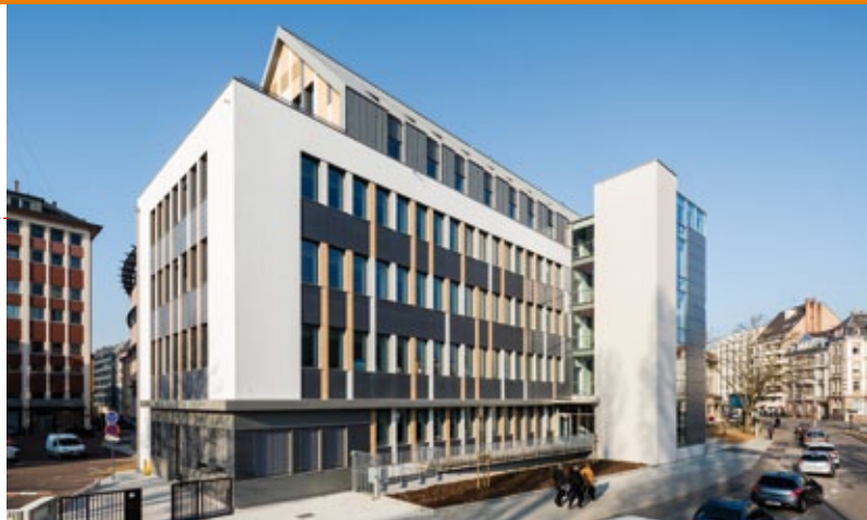
↓ Parking des H.U.S. à Hautepierre, Nogha Consulting, 2015
