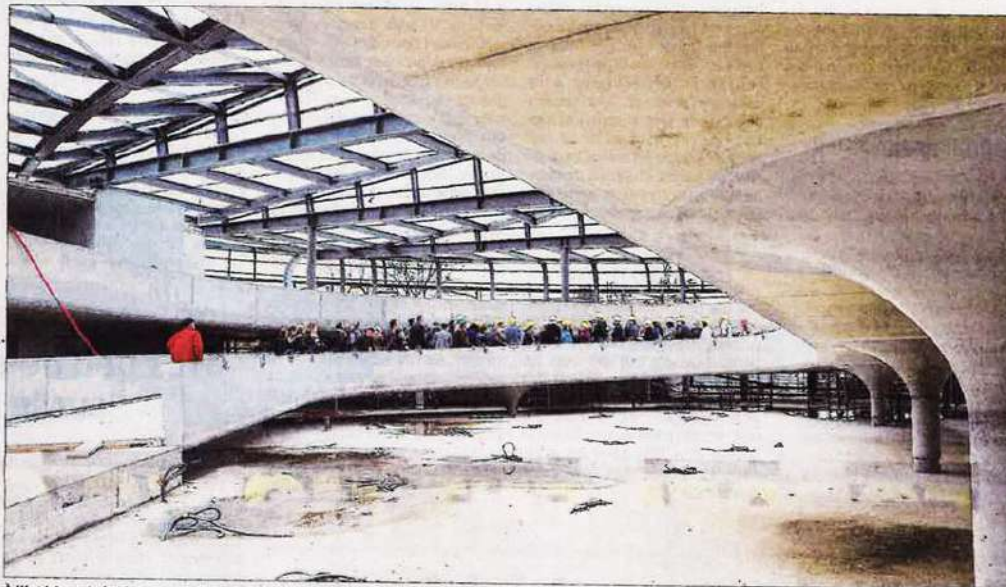
À l'intérieur du bâtiment, une longue rampe de béton relie le rez-de-chaussée au premier étage en mezzanine...
