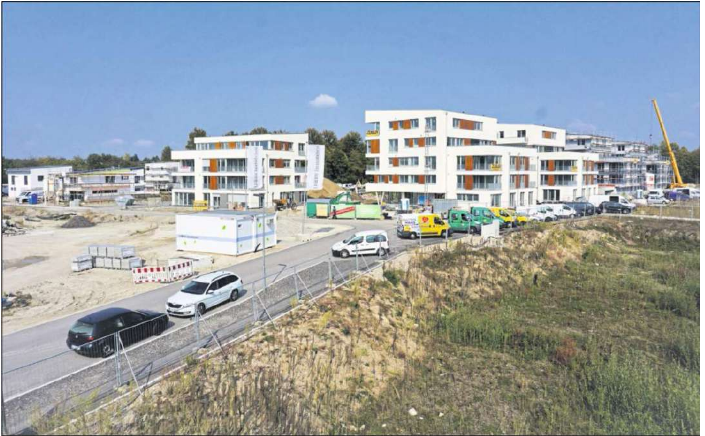
DIE BALDENAUA, FRÜHERER STANDORT DER SPARKASSENKADEMIE, ist nur ein Ziel der Radtour, bei der Architekten den Teilnehmern die Besonderheiten des Wohnens auf Konversionsflächen erläutern. Foto: Collet
