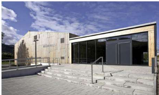
Beispielhaft: die Belchenhalle in Staufen Foto: Architektenkammer
