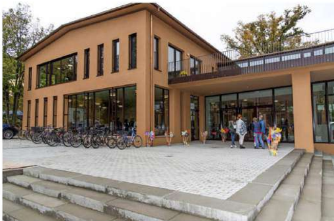
Neubau des August-Ruf-Bildungszentrums mit Mensa Foto: privat
