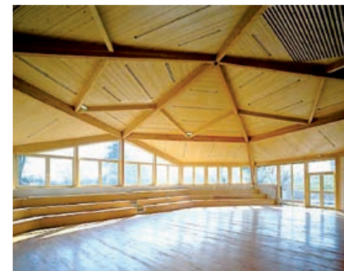
Coupole en bois massif ©Brolly et Mosser architectes
