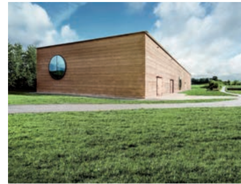
Maison des plantes Ricola, Laufen, Suisse, 2014, Herzog & de Meuron. Façade en pisé réalisée en collaboration avec Martin Rauch © Markus Bühler
