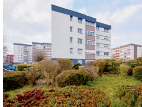
Réhabilitation de Éléonore 1, quartier de HautePierre © Christian Creutz – EMS
