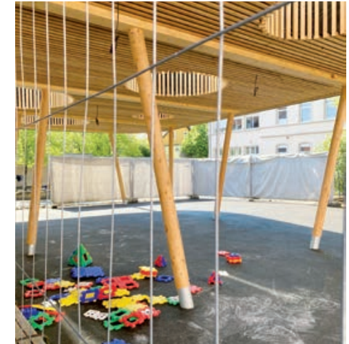
Préau de l'école de Brunstatt ©Esquisse architecture
