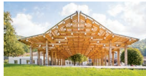
Halle et périscolaire de Tendon ©HAHA
