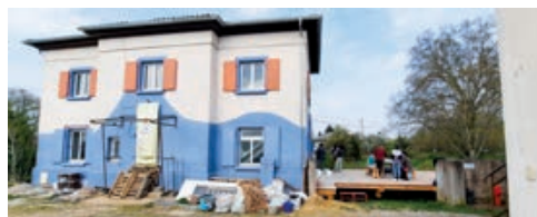
L'Orée 85, maison éclusière transformée en tiers lieu ©Vincent Leport
