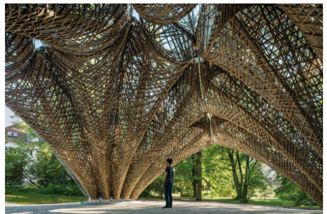
Pavillon « livMatS » avec structure porteuse en fibres de lin - Institut ICD et ITKE de Stuttgart
