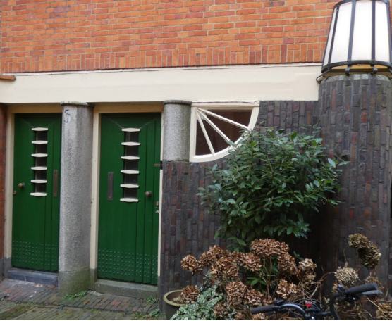
Gebäude «Het Schip» (Das Schiff) - Hinterhof, Eingänge zu den Sozialwohnungen © EM_Langerijs
