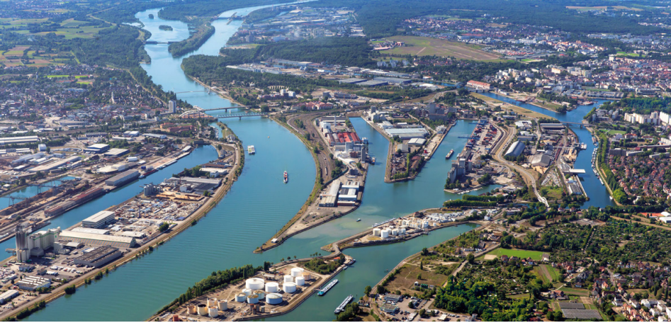
Vue aérienne du Port autonome de Strasbourg © Frantisek Zvardon
