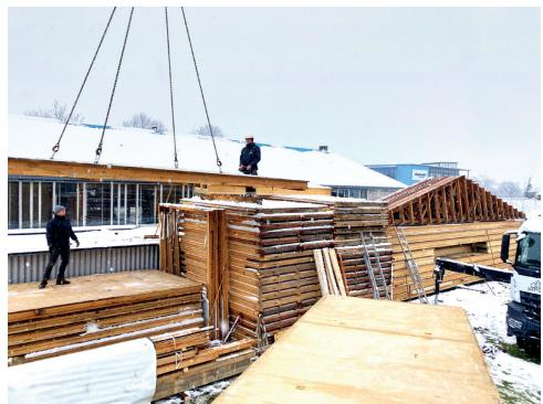
Déchargement des éléments de structure ©atelier bleu
