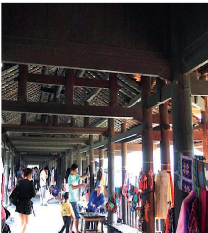
Le **Pont de Yongji de Chényàng** dans la région autonome Zhuang du Guangxi (Chine). Construit en bois sur cinq piles de pierre, il a été achevé en 1916. Chaque pile est surmontée d'une tour à l'apparence de pagode. Leur fonction est avant tout de célébrer l'esprit supposé y habiter et accessoirement de franchir une rivière. C'est aussi un lieu parfait pour des stands marchands.
