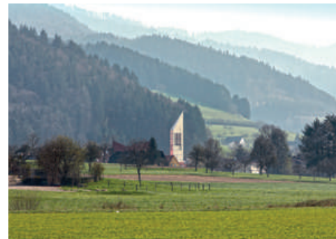
Kirchturn Gutach-Bleibach im Breisgau © WerkGruppe 1 Holding GmbH Oliver Kern
