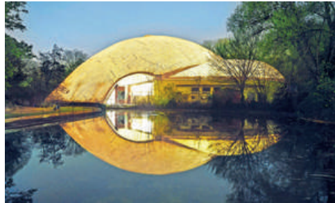
Multihalle (Architekten: Carlfried Mutschler, Joachim Langner, Frei Otto) © Daniel Lukac
