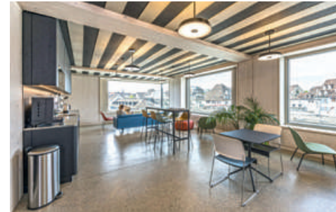
Cafeteria - sichtbare Holz-Beton-Struktur des Gebäudes © Kathrin Schulthess
