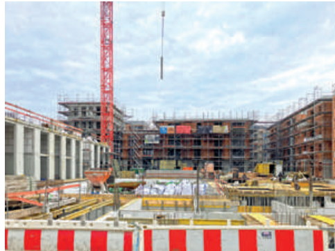
Baustellenfoto © AAg Architekten
