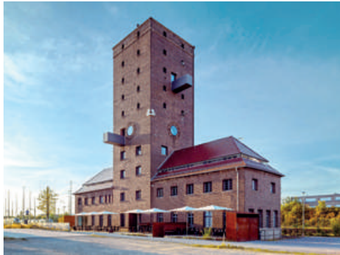
Tankturm Außenansicht © Thilo Ross
