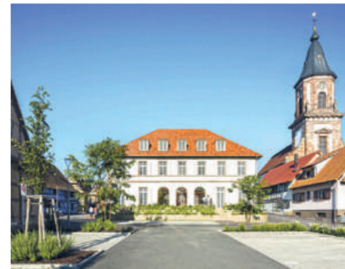
Restructuration de la mairie de Weyersheim © Scherrer & Boetsch Architectes
