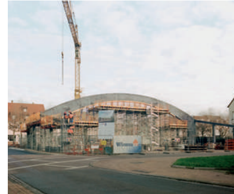
La halle – phase gros-œuvre © Guillaume Porche
