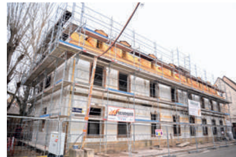
Façade principale de la crèche en travaux © EMS-DAP
