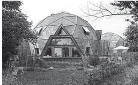
Kuppelhäuser in Mannheim-Neckarau © MARCHIVUM
