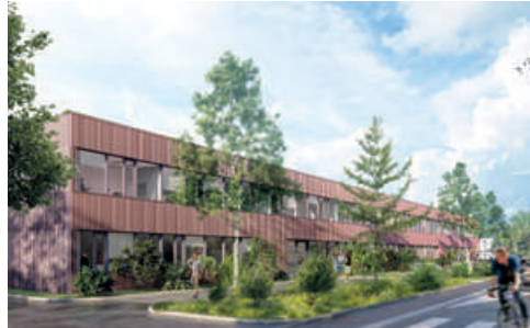
Le nouveau siège de Stabulo France après sa réhabilitation © ballast architectes + théo chemin
