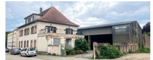
Projet friche Staat © LAMA Architectes
