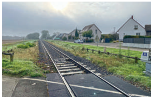
Ligne ferroviaire Colmar-Neuf-Brisach © Dominik Neidlinger
