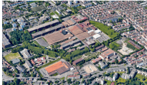
Vue aérienne du site DMC © Google Earth
