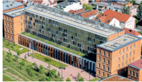
Résidence Junior © TOA architectes
