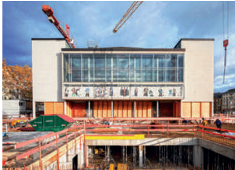
Nationaltheater Mannheim (Architekt: Gerhard Weber) Baustelle © Christian Kleiner
