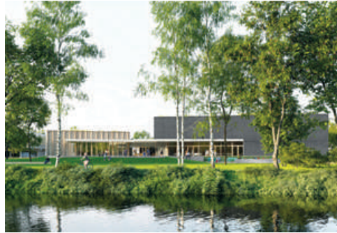
Vue de la façade sud: ouverture des salles de spectacle sur le jardin © Dominique Coulon & associés / Artefactorylab
