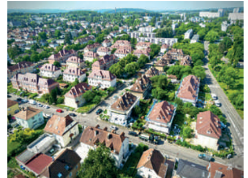
Vue d'ensemble du quartier © drlw architectes
