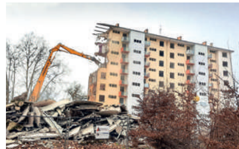
Démolition d'un immeuble, rue de Bourgogne © Vincent Leport
