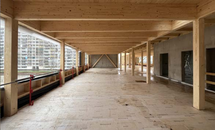
Structure bois dans les futures salles de classe © buob architecte
